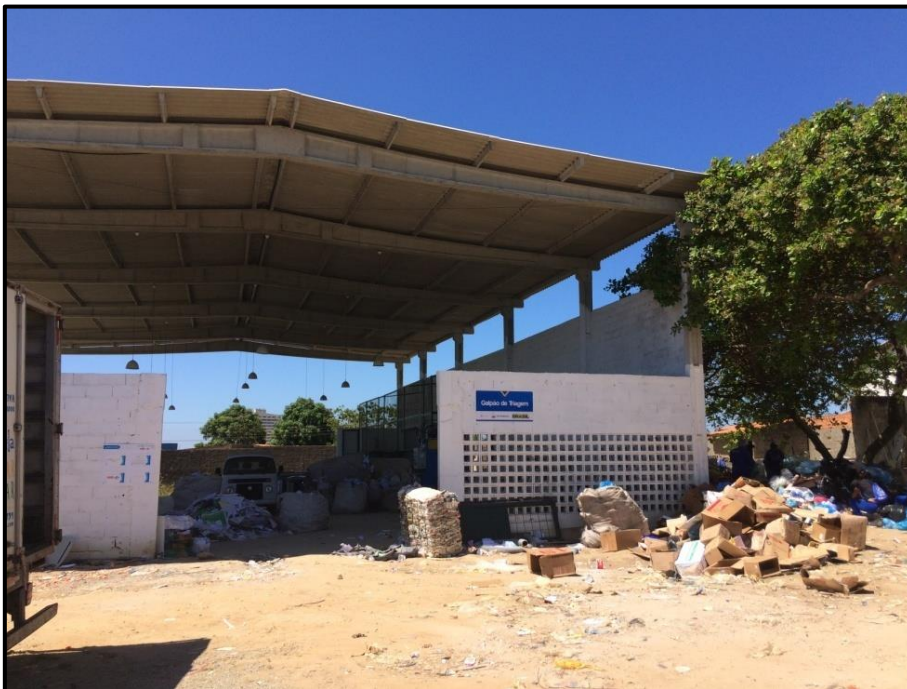
Figura 43. Vista da COOPVILA em novembro/2016. Fonte: registro fotográfico da SLUM.
