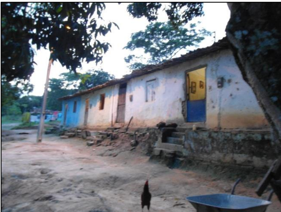
Figura 21. Comunidade rural de Engenho Velho. Fonte: registro fotográfico dos autores.
