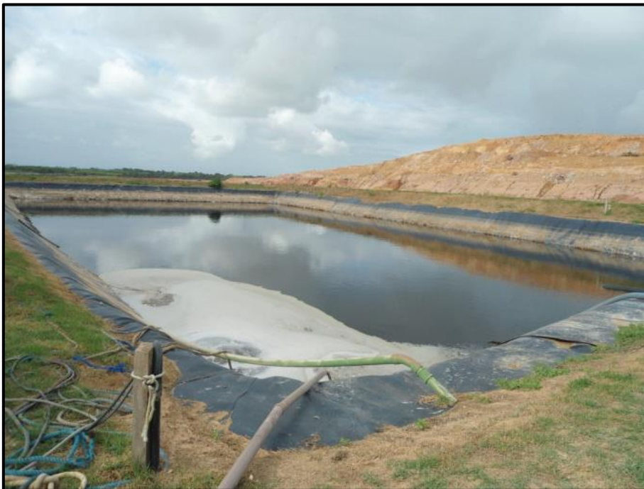
Figura 28. Registro fotográfico da lagoa de polimento final. Fonte: registro fotográfico dos autores.
