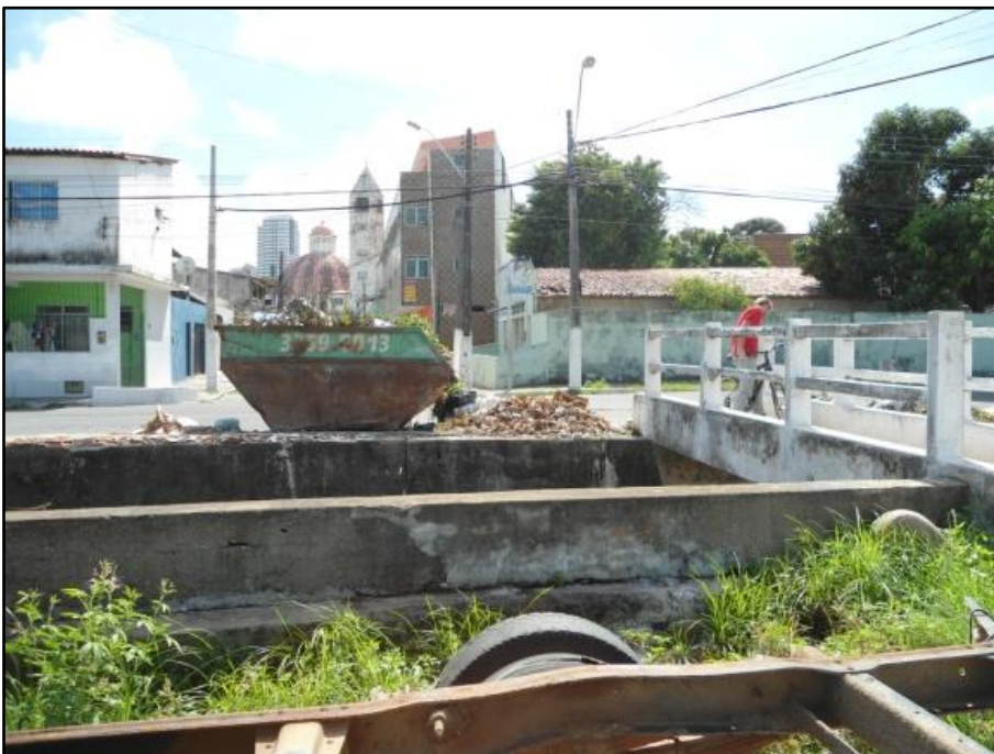
Figura 12. Caixa estacionária localizada em um dos canais revestidos de Maceió. Fonte: registro fotográfico dos autores.
