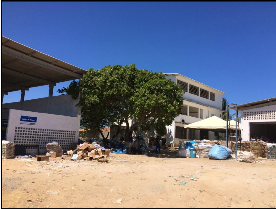
Figura 42. Vista da COOPVILA em novembro/2016. Fonte: registro fotográfico da SLUM.
