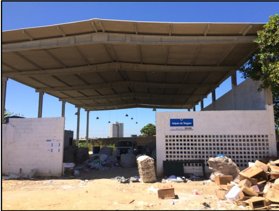
Figura 44. Vista da COOPVILA em novembro/2016. Fonte: registro fotográfico da SLUM.
