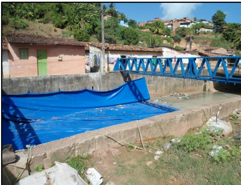
Figura 56. Registro fotográfico da barragem hidráulica do Vale do Reginaldo. Fonte: registro fotográfico dos autores.
