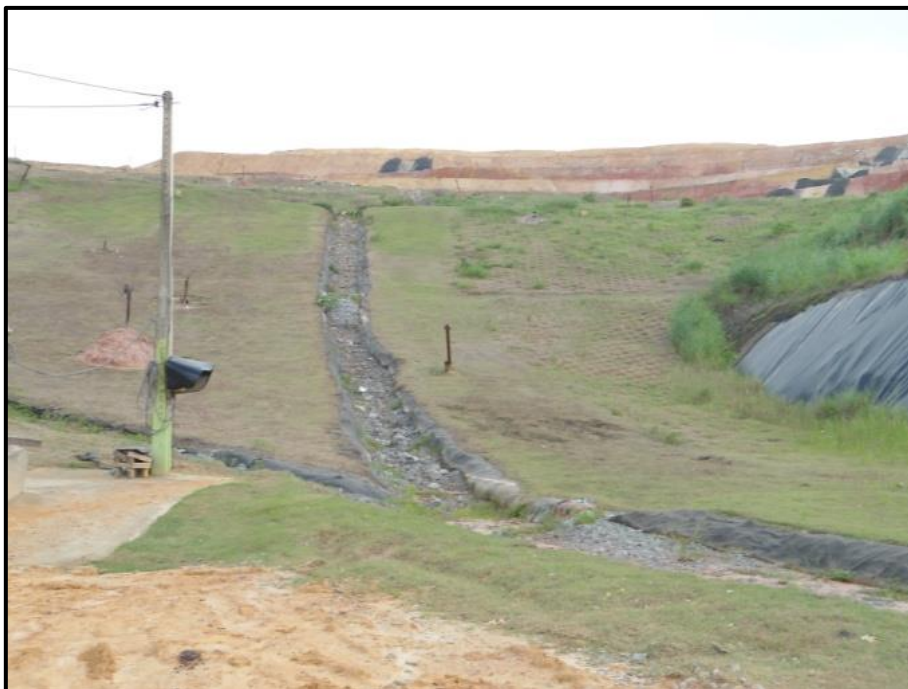
Figura 25. Célula de aterramento com cobertura vegetal (gramíneas) e drenos de gases. Fonte: registro fotográfico dos autores.
