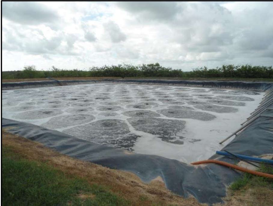
Figura 26. Registro fotográfico da lagoa aerada. Fonte: registro fotográfico dos autores.
