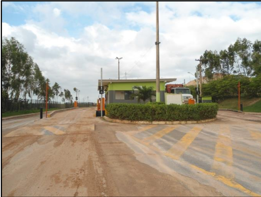
Figura 23. Portaria de entrada e balança rodoviária - CTRA/MA. Fonte: registro fotográfico dos autores.
