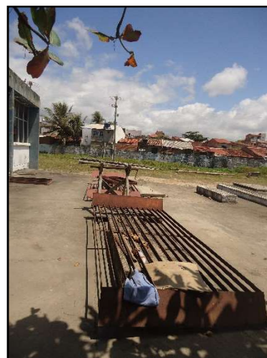
Figuras 76 e 77. Unidades de Gradeamento da ETE – Disposição Oceânica e detalhe para Gradeamentos não instalados. Fonte: MJ Engenharia
