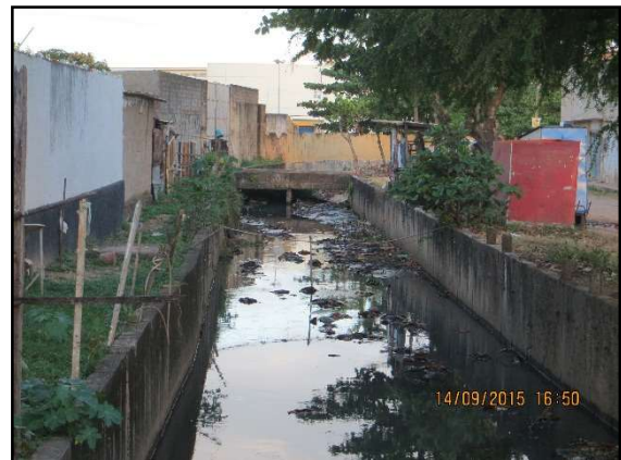
Figuras 138 e 139. Esgoto presente na rede pluvial do bairro Ponta Grossa e riacho comprometido pela poluição no bairro Vergel do Lago. Fonte: MJ Engenharia
