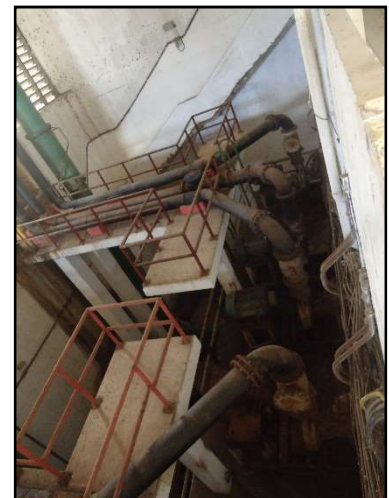
Figuras 79 e 80. Os 6 GMBs menores que formam os conjuntos Emissário I e II. Fonte: MJ Engenharia.
