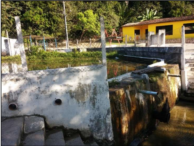
Figura 55. Barragem do Riacho Aviação. Fonte: MJ Engenharia
