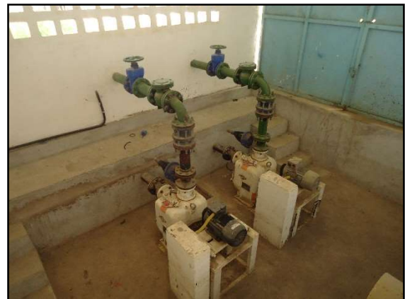
Figuras 158 e 159. GMBs das ETES Recanto das Estrelas e Village das Artes. Fonte: MJ Engenharia
