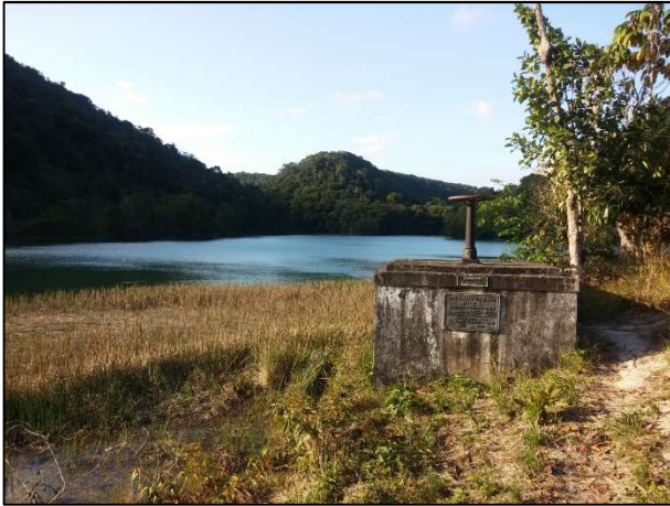
Figura 53. Barragem do Riacho Catolé. Fonte: MJ Engenharia
