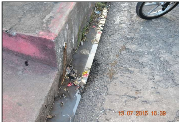
Figuras 138 e 139. Esgoto presente na rede pluvial do bairro Ponta Grossa e riacho comprometido pela poluição no bairro Vergel do Lago. Fonte: MJ Engenharia
