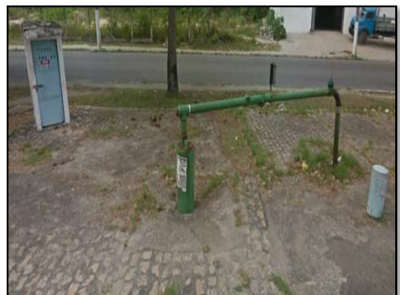
Figura 48. Poço de captação da CASAL
