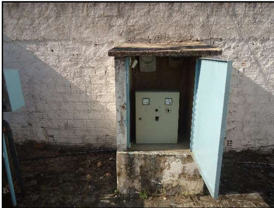
Figuras 107 e 108. Detalhe do quadro de comando e das instalações elétricas da EEE – Santo Eduardo. Fonte: MJ Engenharia
