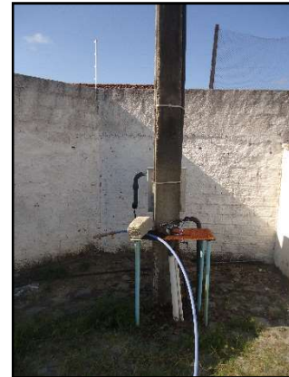
Figuras 107 e 108. Detalhe do quadro de comando e das instalações elétricas da EEE – Santo Eduardo. Fonte: MJ Engenharia
