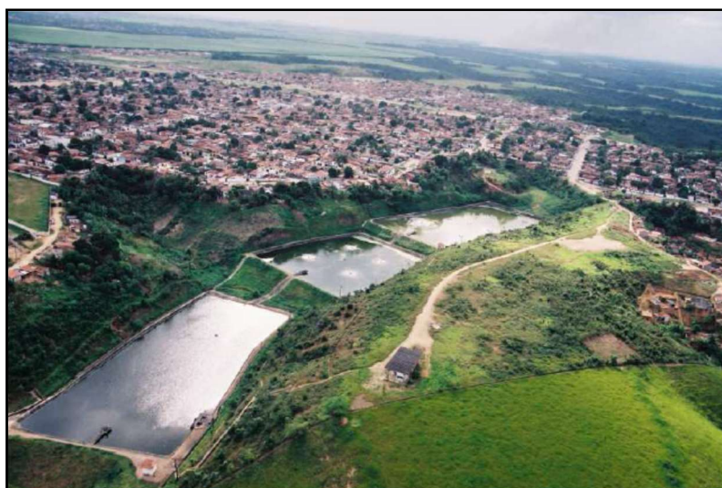
Figura 144. Vista aérea do sistema de tratamento por lagoas de estabilização de Benedito Bentes. Fonte: Maceió, IBAM, 2005
