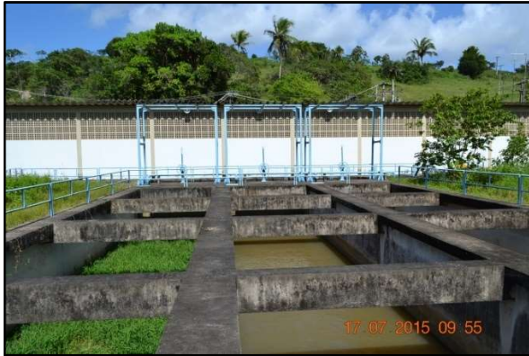
Figura 51. Entrada da captação. Fonte: MJ Engenharia
