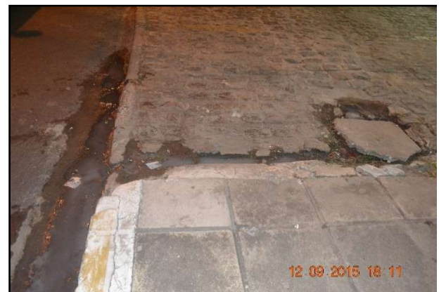
Figuras 111 e 112. Extravasamento de esgoto sanitário no bairro Ponta Verde. Fonte: MJ Engenharia
