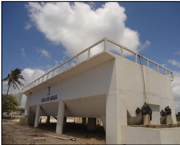
Figuras 83 e 84. Vistas da caixa de areia da ETE – Disposição Oceânica. Fonte: MJ Engenharia
