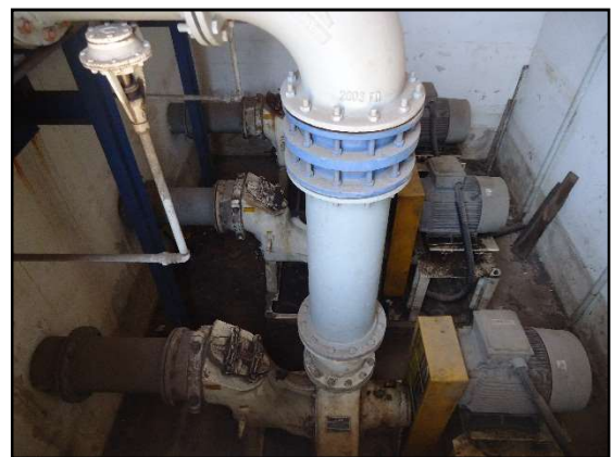
Figuras 124 e 125. Vista Geral e dos GMBs da EEE – Levada. Fonte: MJ Engenharia
