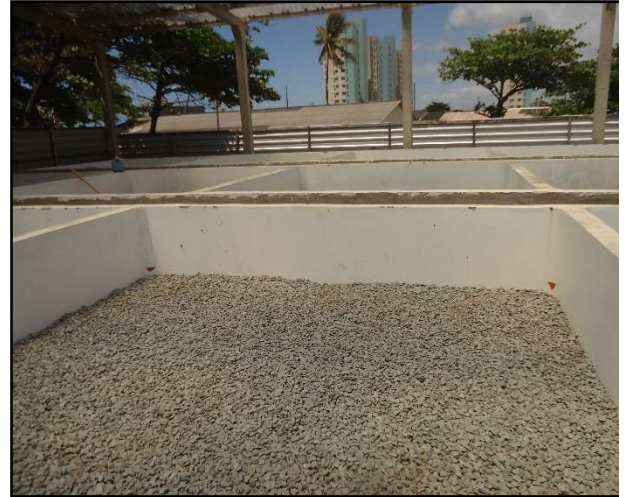
Figuras 87 e 88. Leitões de Secagem em Construção. Fonte: MJ Engenharia
