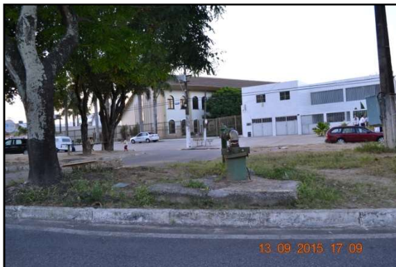
Figura 41. Poço de captação da CASAL
