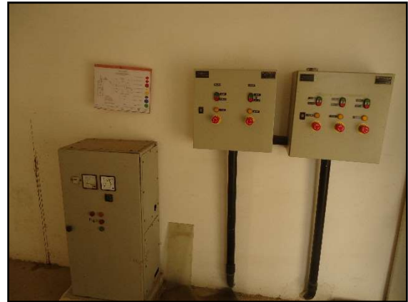
Figuras 156 e 157. Câmara de chegada da ETE Recanto das Estrelas e Quadro de Comando da EEE Village das Artes. Fonte: MJ Engenharia
