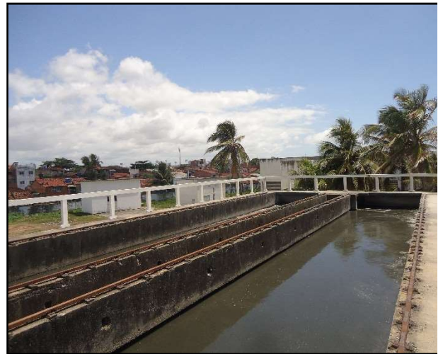
Figuras 83 e 84. Vistas da caixa de areia da ETE – Disposição Oceânica. Fonte: MJ Engenharia
