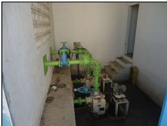
Figuras 158 e 159. GMBs das ETES Recanto das Estrelas e Village das Artes. Fonte: MJ Engenharia
