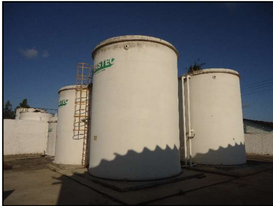
Figuras 154 e 155. Tanques aerados das ETEs Recanto das Estrelas e Village das Artes. Fonte: MJ Engenharia
