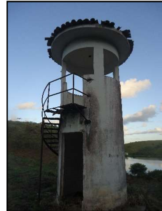
Figuras 148 e 149. Vegetação sobre a câmara de chegada e estrutura da ETE comprometida. Fonte: MJ Engenharia
