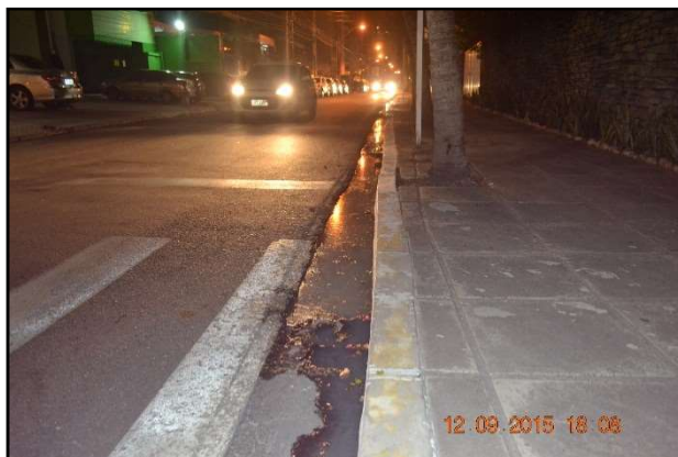
Figuras 111 e 112. Extravasamento de esgoto sanitário no bairro Ponta Verde. Fonte: MJ Engenharia
