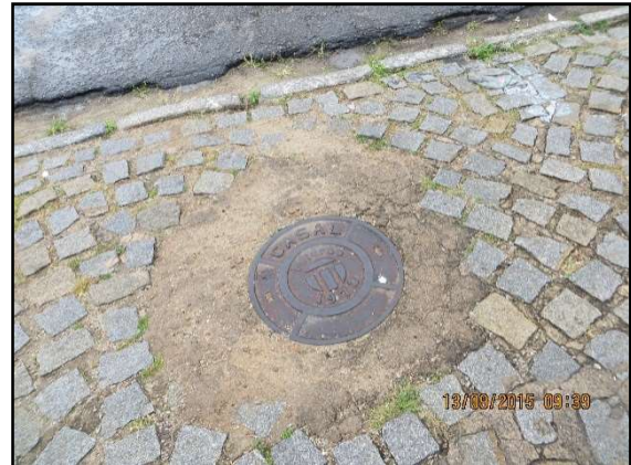
Figuras 92 e 93. Poços de visita da rede coletora existente nos bairros Jaraguá e Pajuçara, respectivamente. Fonte: MJ Engenharia
