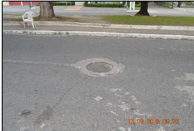
Figuras 92 e 93. Poços de visita da rede coletora existente nos bairros Jaraguá e Pajuçara, respectivamente. Fonte: MJ Engenharia
