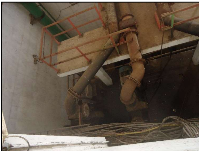
Figuras 79 e 80. Os 6 GMBs menores que formam os conjuntos Emissário I e II. Fonte: MJ Engenharia.
