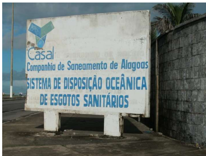
Figura 73. Placa de Identificação do Sistema de Disposição Oceânica de Esgotos de Maceió. Fonte: PERRELLI FILHO E AMARAL (2009)
