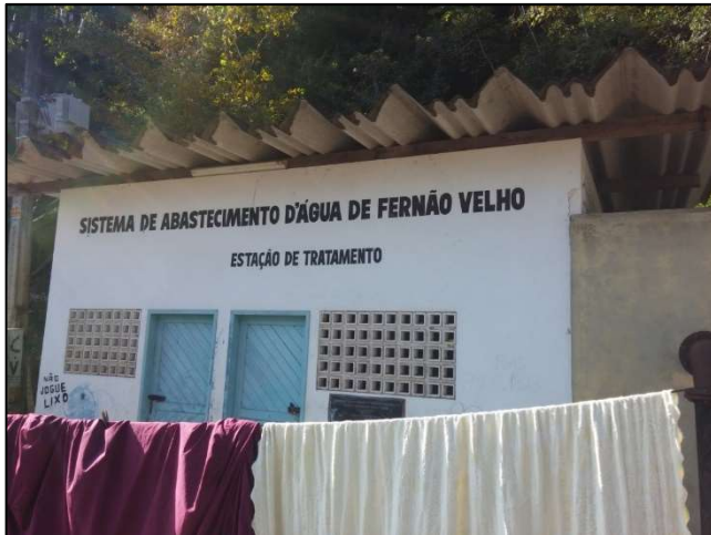
Figura 67. Casa de máquinas da ETA Fernão Velho. Fonte: MJ Engenharia.
