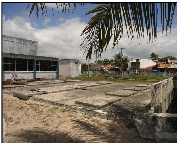
Figuras 76 e 77. Unidades de Gradeamento da ETE – Disposição Oceânica e detalhe para Gradeamentos não instalados. Fonte: MJ Engenharia
