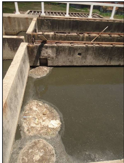
Figuras 85 e 86. Detalhes da Caixa de Areia em funcionamento. Fonte: MJ Engenharia
