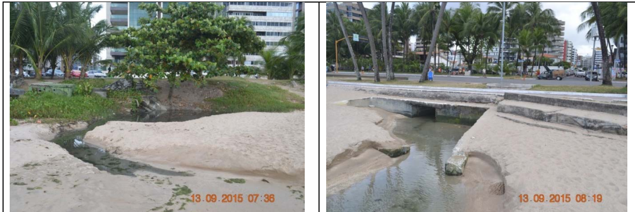
Figura 36: Chegada de esgoto pluvial na orla, onde se constata presença de esgotos cloacais sem devido tratamento. Fonte: Autor, setembro/2015.
