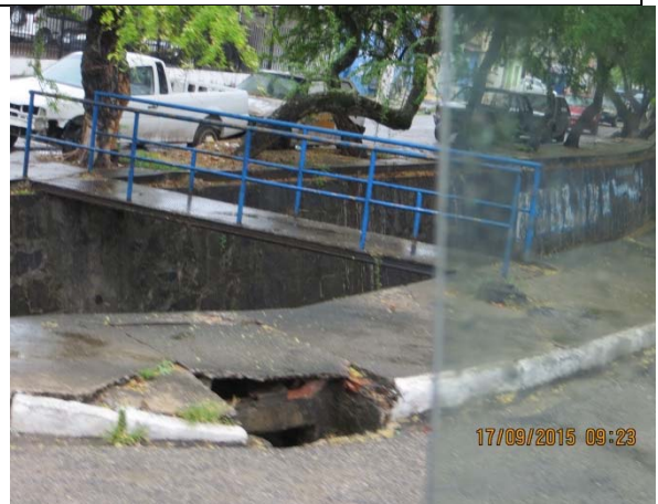
Figura 31: Riacho do Sapo – Canal aberto, paredes revestidas em concreto armado, com 2.415 m. Riacho Gulandim – Canal aberto paredes e fundo revestidos em concreto armado, com 1.950 m. Fonte: Autor. Base Google Earth e vistoria “in loco”.
