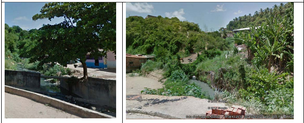
Figura 32: Riacho Pau D'arco – Canal aberto sem revestimento, com 3.460 m. Fonte: Autor. Base Google Earth e vistoria “in loco”.
