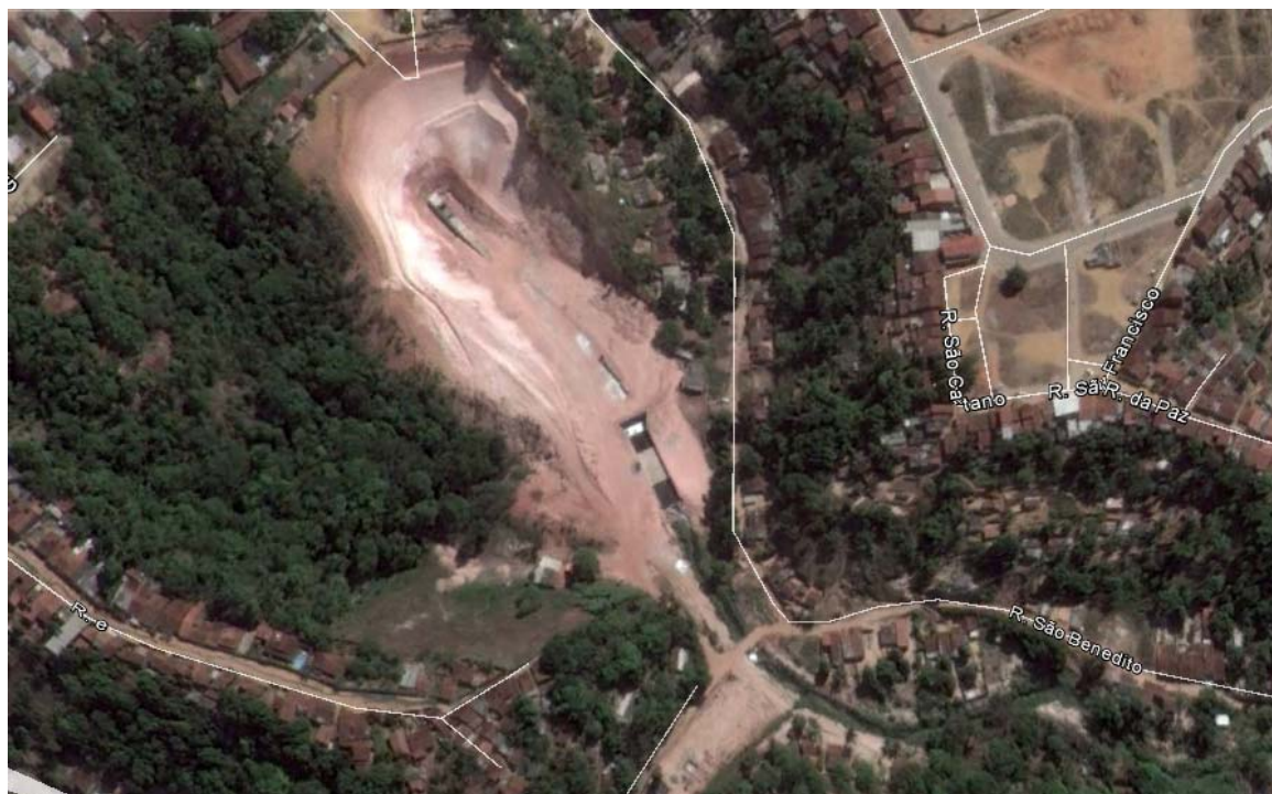
Figura 45: Dissipação de Energia e contenção de encosta da estrutura de macrodrenagem da Bacia Endorréica. Fonte: Google Earth – Consulta em outubro/2015, e imagem de abril/2015.
