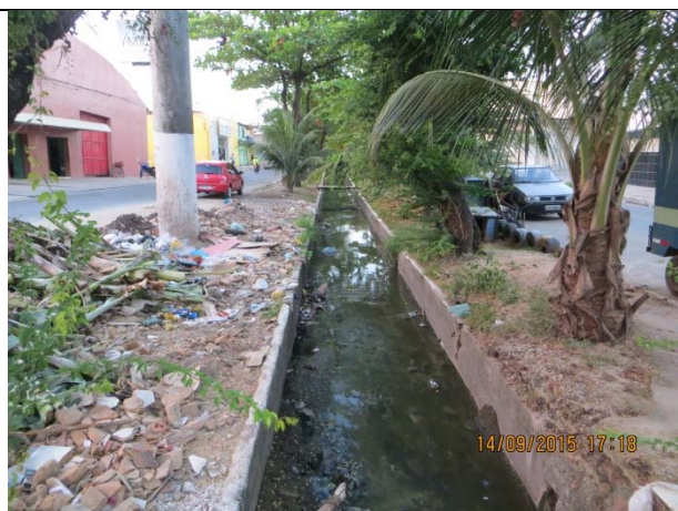
Figura 26: Avenida Celeste Bezerra – Canal aberto, paredes revestidas em concreto armado, com extensão de 525 m. Rua João Calheiros Gato – Canal aberto, paredes revestidas em concreto armado, com extensão de 475 m. Fonte: Autor. Base Google Earth e vistoria “in loco”.
