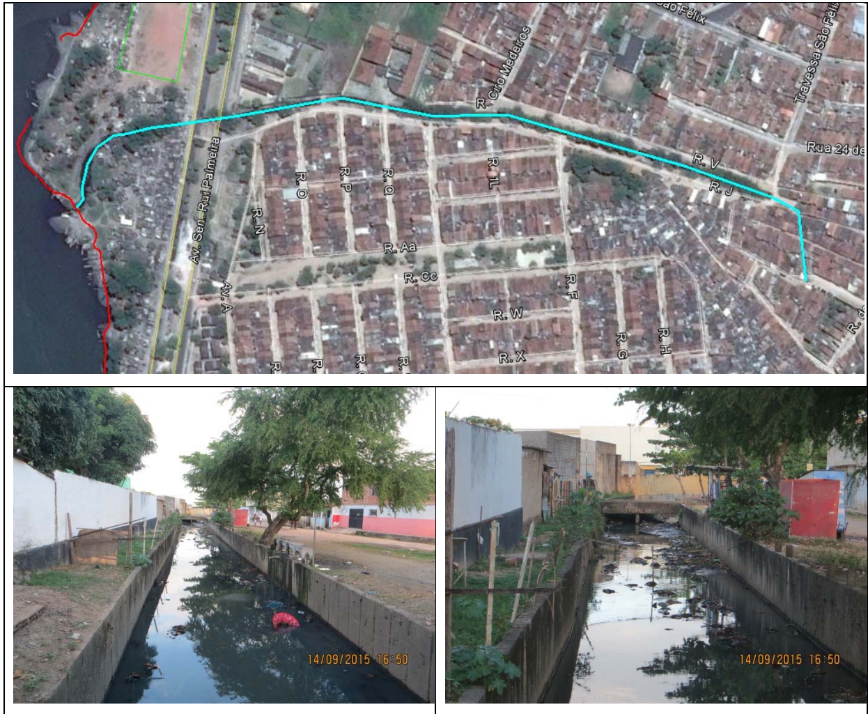
Figura 27: Virgem dos Pobres III – Canal Aberto Paredes revestidas em concreto armado, com extensão de 780 m. Fonte: Autor. Base Google Earth e vistoria “in loco”.
