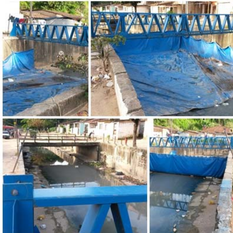
Figura 19: Barragem hidráulica no Riacho Reginaldo. Fonte: registro fotográfico dos autores.
