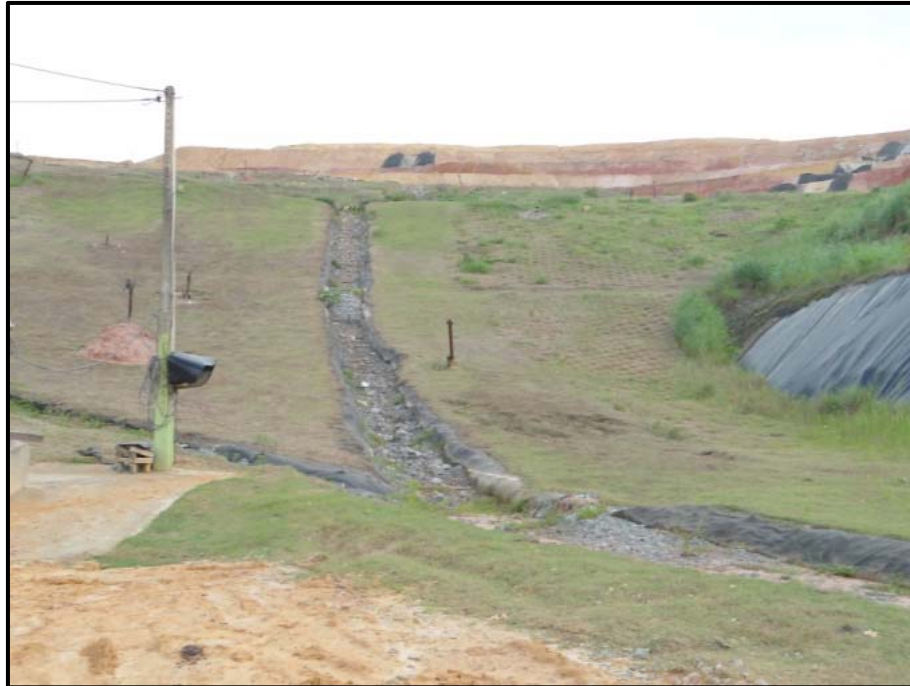
Figura 30. Célula de aterramento com cobertura vegetal (gramíneas) e drenos de gases. Fonte: registro fotográfico dos autores.
