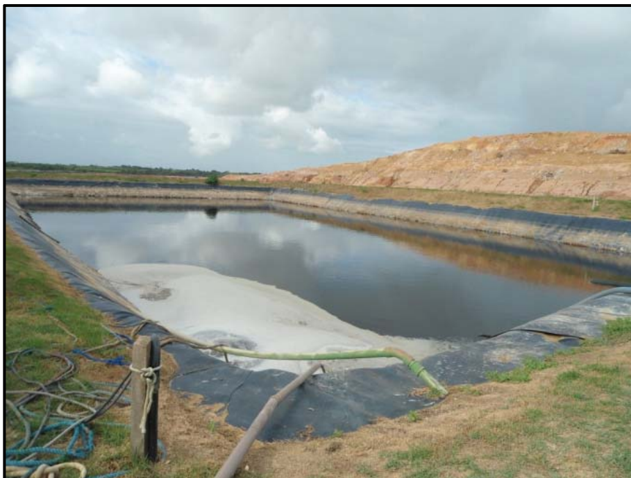
Figura 33. Registro fotográfico da lagoa de polimento final.
