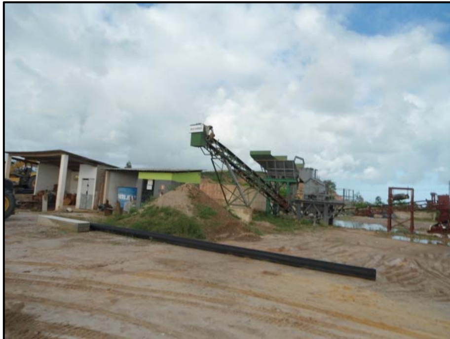
Figura 58. Registro fotográfico da URI. Fonte: registro fotográfico dos autores.
