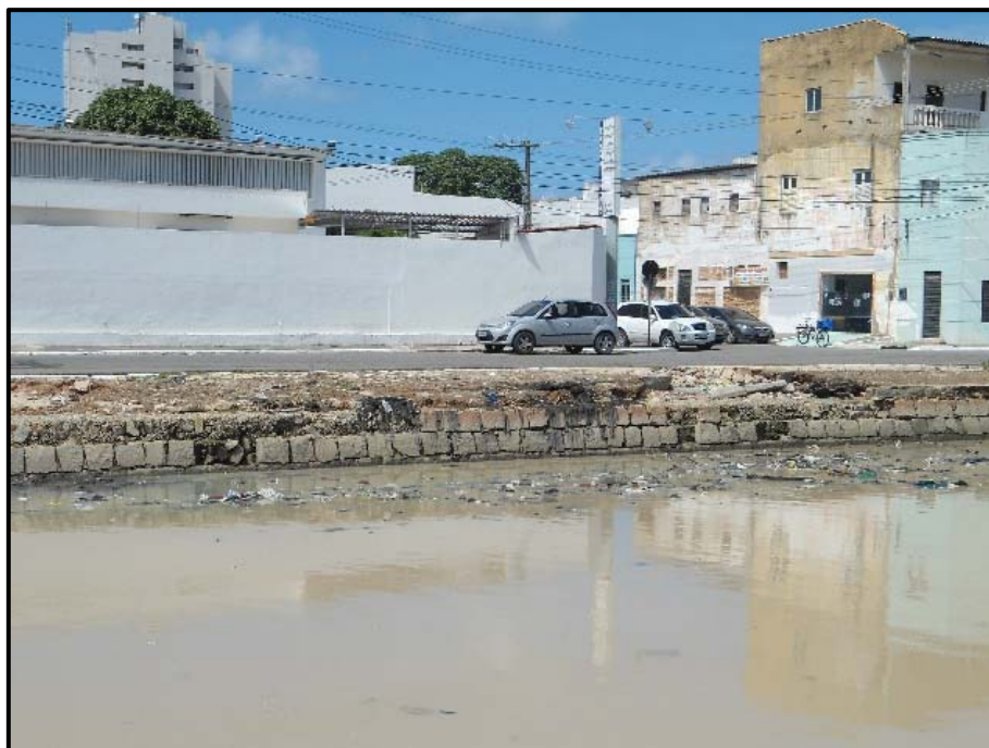
Figura 52. Ponto de lixo localizado nas margens do Riacho Salgadinho.
