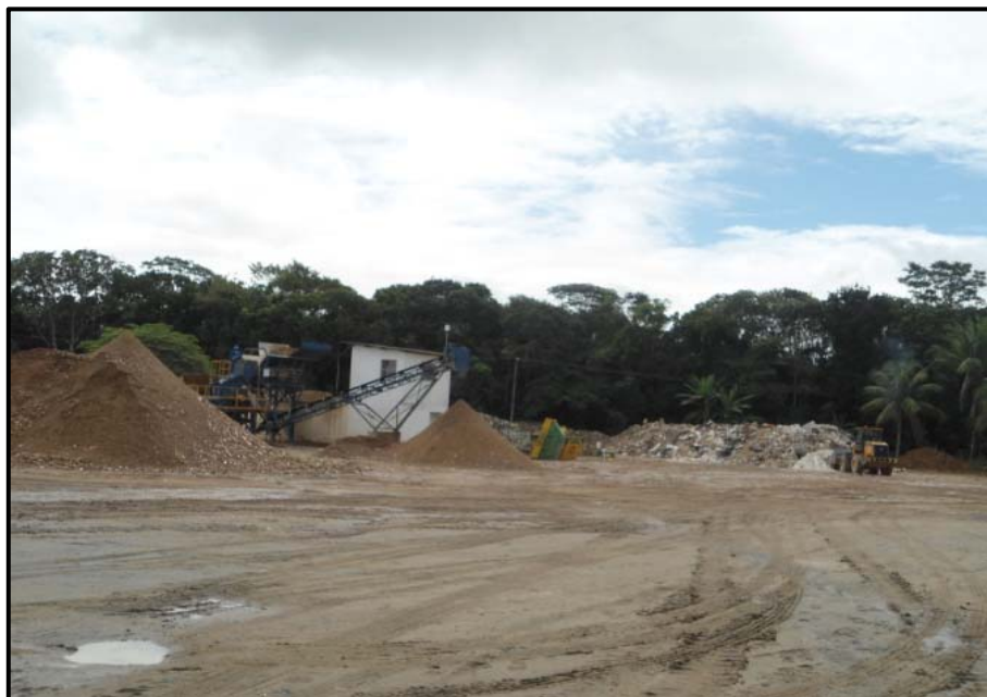
Figura 60. Registro fotográfico da URI. Fonte: registro fotográfico dos autores.
