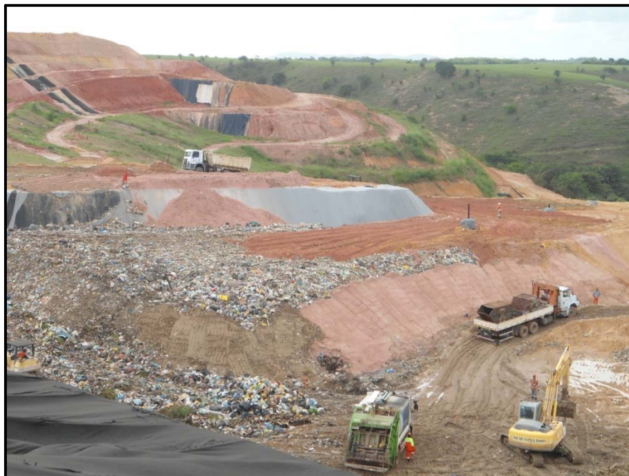
Figura 29. Vista da frente de serviço do aterro sanitário - CTRA/MA. Fonte: registro fotográfico dos autores.
