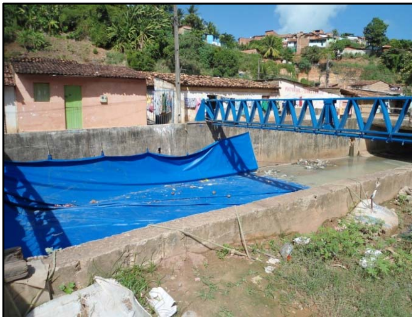
Figura 55. Registro fotográfico da barragem hidráulica do Vale do Reginaldo.
