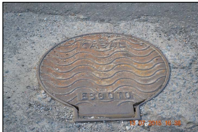
Figuras 78 e 79. Poços de visita da rede coletora existente nos bairros Ponta Grossa e Centro, respectivamente.
