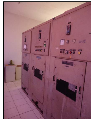
Figuras 31 e 32. Quadros de comando primeira dos conjuntos I e II, e depois o do conjunto III
