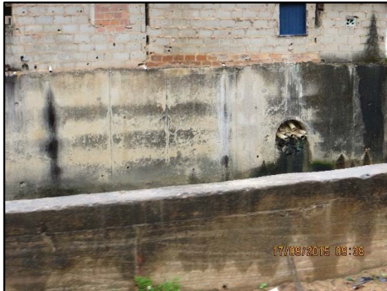
Figuras 74 e 75. Tubulações de Esgoto conectadas diretamente no riacho Reginaldo
