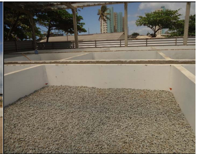
Figuras 37 e 38. Leitos de Secagem em Construção
