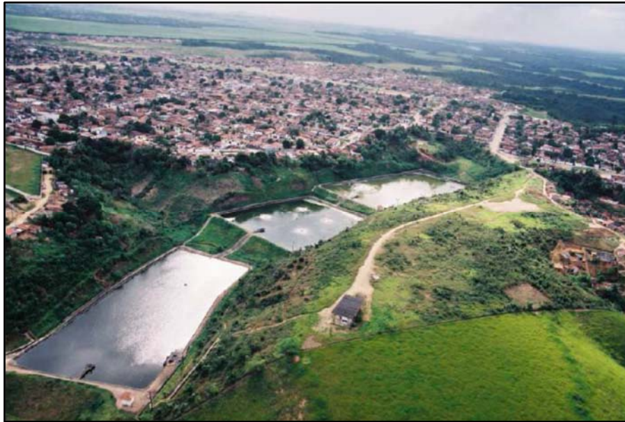
Figura 104. Vista aérea do sistema de tratamento por lagoas de estabilização de Benedito Bentes
