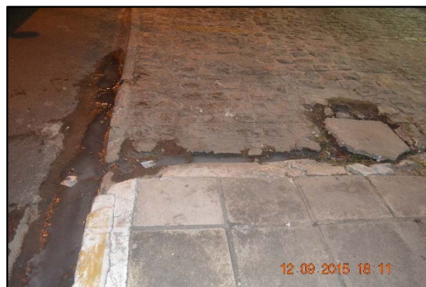
Figuras 65 e 66. Extravasamento de esgoto sanitário no bairro Ponta Verde
