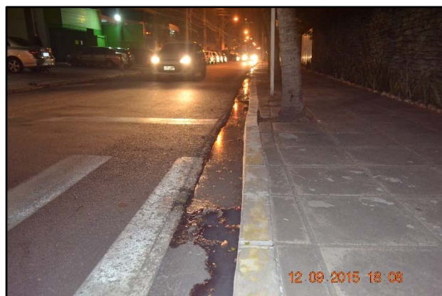
Figuras 65 e 66. Extravasamento de esgoto sanitário no bairro Ponta Verde
