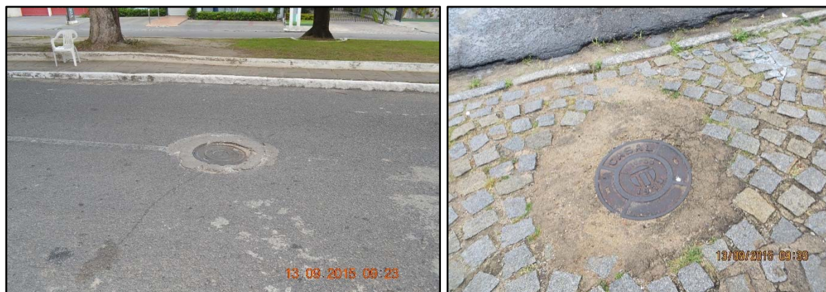
Figuras 42 e 43. Poços de visita da rede coletora existente nos bairros Jaraguá e Pajuçara, respectivamente.
