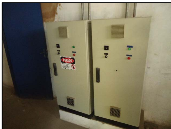
Figuras 84 e 85. Detalhe do quadro de comando e do gerado da EEE – Jardim Esperança.
