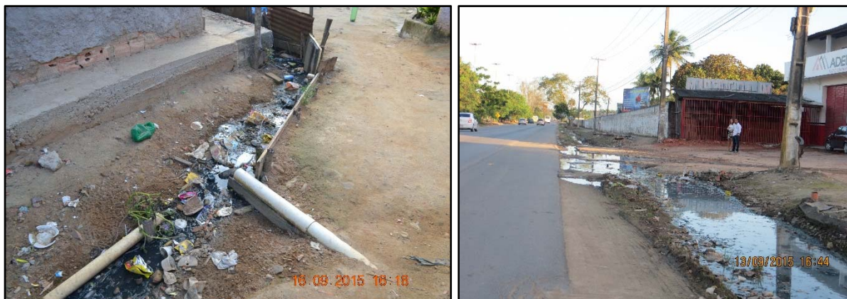
Figuras 124 e 125. Problemas oriundos da falta de esgotamento sanitário enfrentados pelas populações dos bairros Ipioca e Santos Dumont, respectivamente.
