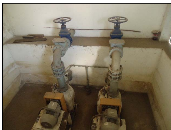
Figuras 82 e 83. Vista da Câmara de Chegada e dos GMBs da EEE – Jardim Esperança.
