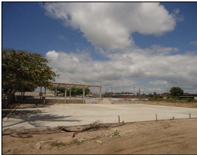
Figuras 37 e 38. Leitos de Secagem em Construção
