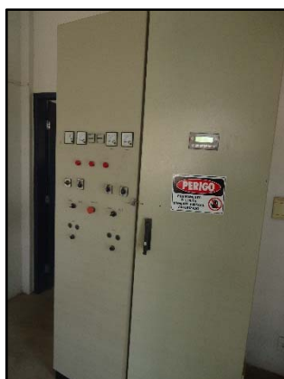
Figuras 88 e 89. Detalhe do quadro de comando e do gerado da EEE – Vergel do Lago.
