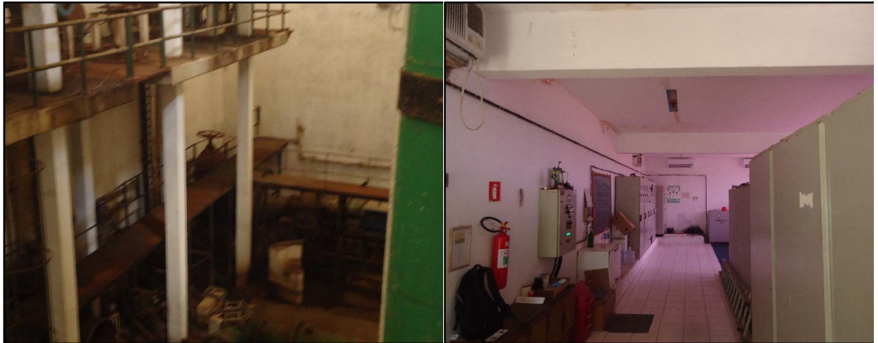
Figuras 29 e 30. Os 2 GMBs que formam o conjunto Emissário III e sala do operador
