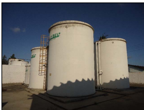
Figuras 115 e 116. Tanques aerados das ETEs Recanto das Estrelas e Village das Artes
