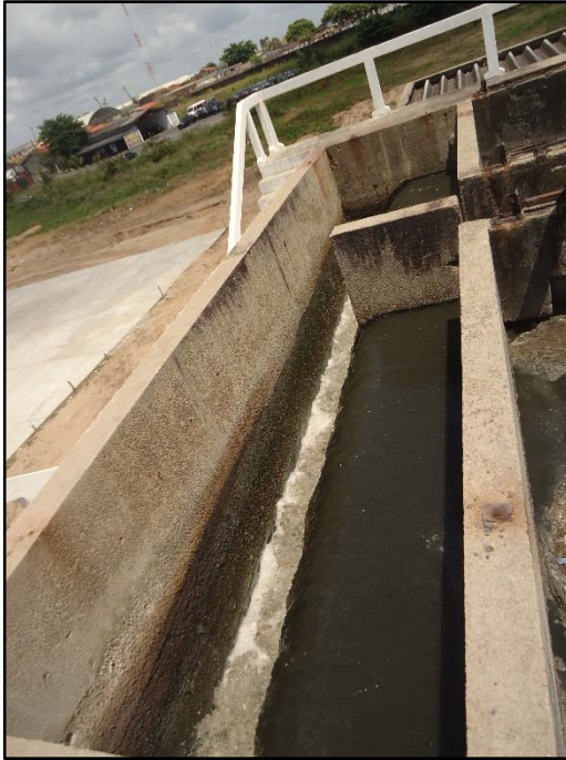
Figuras 35 e 36. Detalhes da Caixa de Areia em funcionamento
