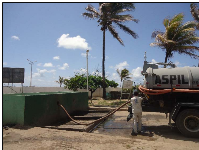
Figura 23. Recebimento de Efluentes de Fossa na Câmara de chegada da ETE
