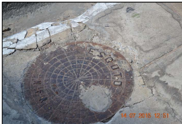
Figuras 78 e 79. Poços de visita da rede coletora existente nos bairros Ponta Grossa e Centro, respectivamente.
