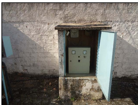
Figuras 61 e 62. Detalhe do quadro de comando e das instalações elétricas da EEE – Santo Eduardo.
