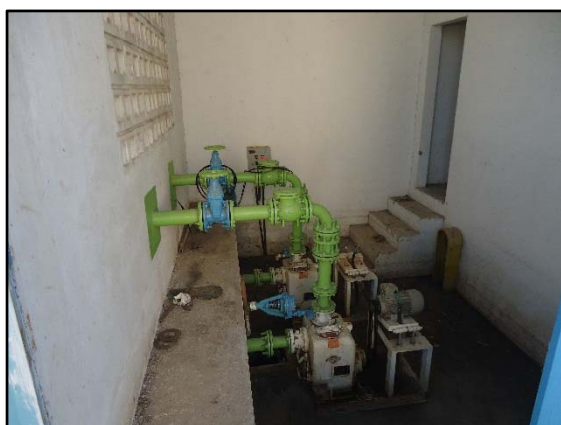
Figuras 119 e 120. GMBs das ETEs Recanto das Estrelas e Village das Artes
