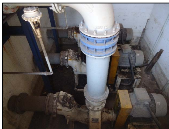
Figuras 80 e 81. Vista Geral e dos GMBs da EEE – Levada.
