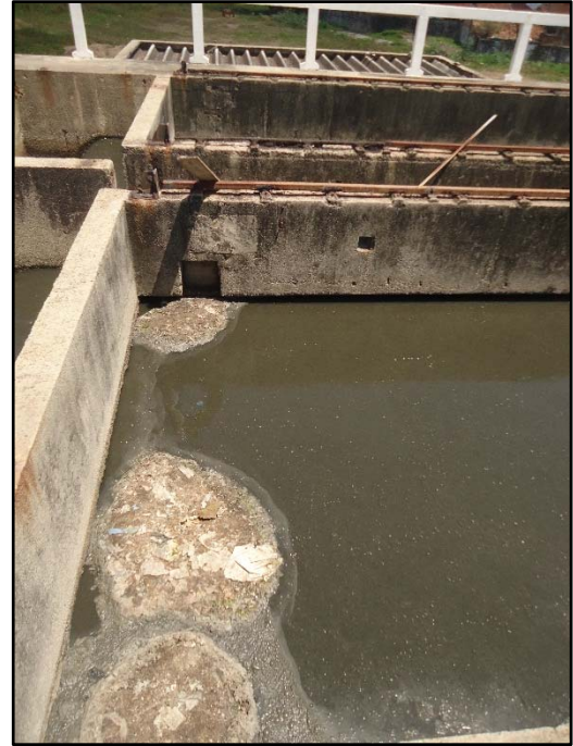
Figuras 35 e 36. Detalhes da Caixa de Areia em funcionamento
