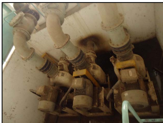
Figuras 94 e 95. Vista dos GMBs e quadro de comando EEE – Trapiche da Barra.
