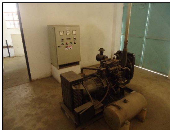
Figuras 84 e 85. Detalhe do quadro de comando e do gerado da EEE – Jardim Esperança.
