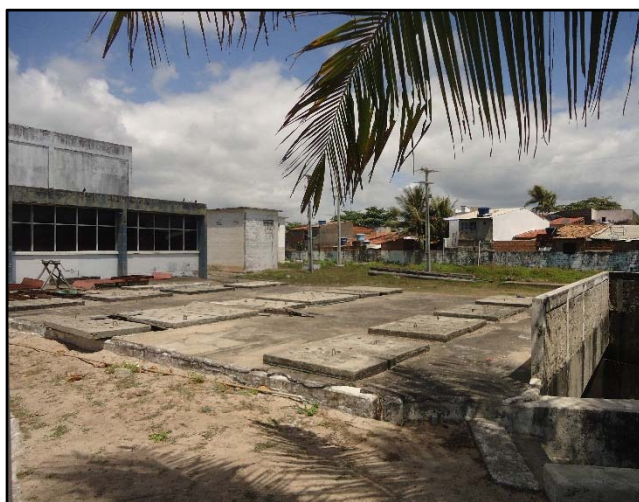
Figuras 24 e 25. Unidades de Gradeamento da ETE – Disposição Oceânica e detalhe para Gradeamentos não instalados.
