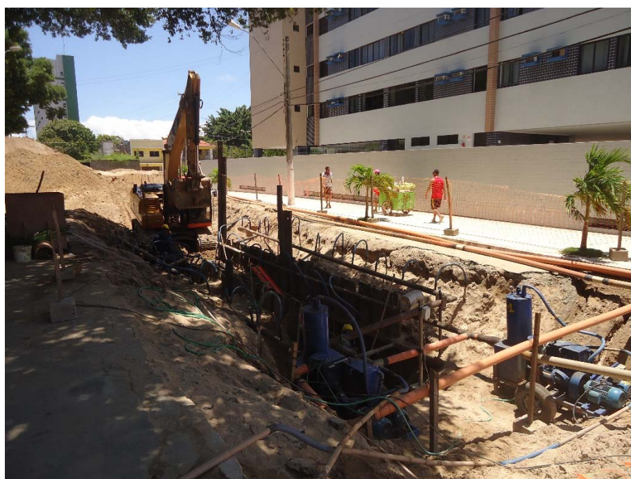
Figura 41. Obras de ampliação da rede coletora de esgotos na bacia Sudeste.
