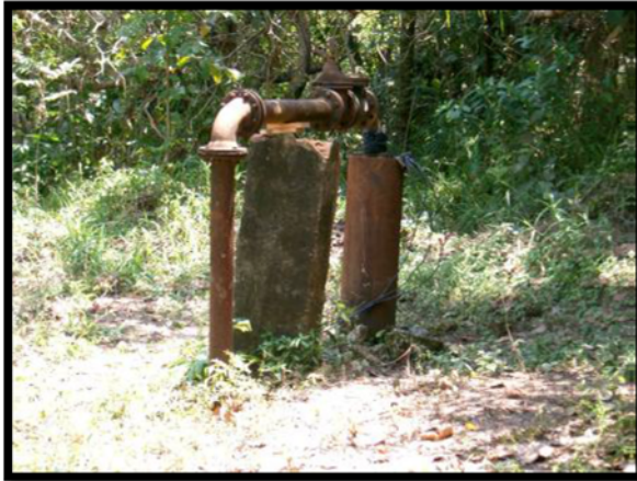
Figura 71. Poço de captação da CASAL
