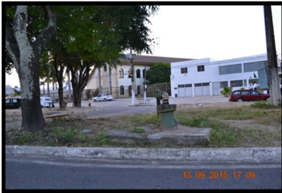
Figura 67. Poço de captação da CASAL
