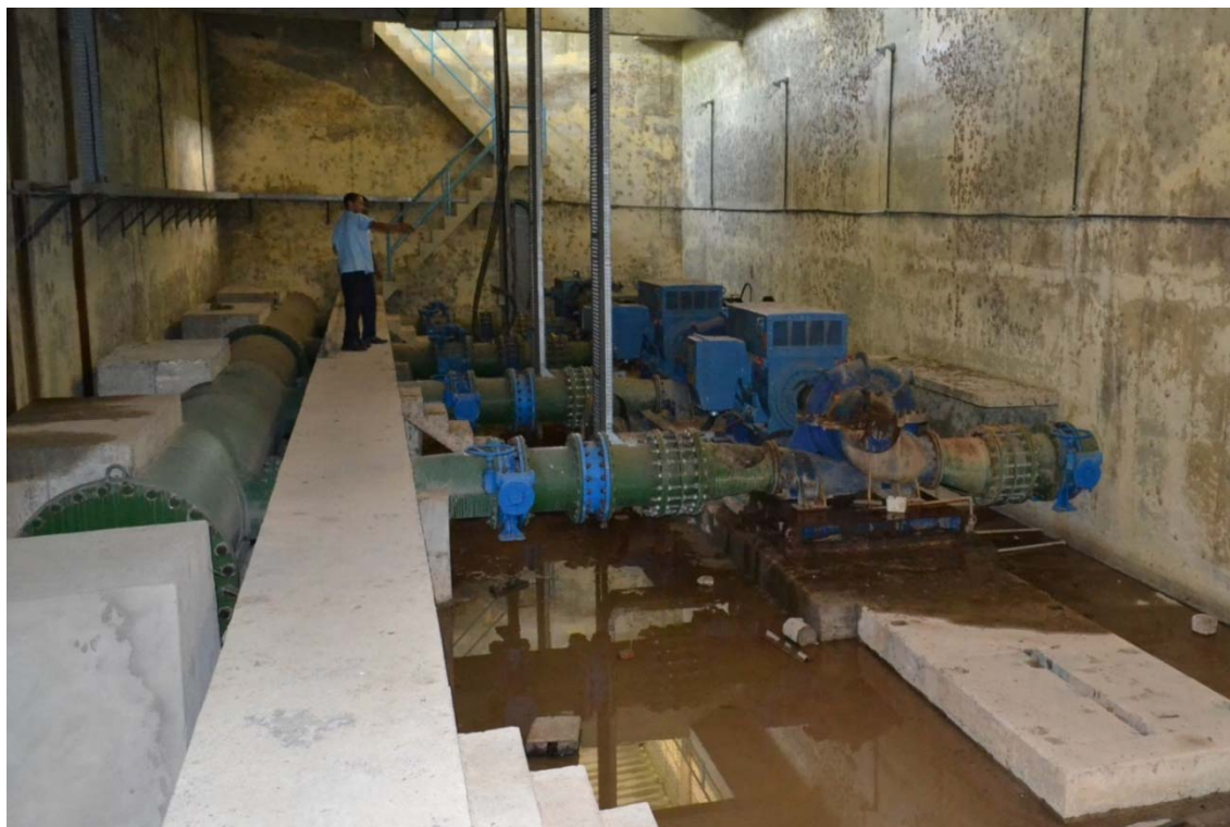
Figura 27. Bombas da Estação de Bombeamento de Água Bruta. Fonte: MJ Engenharia.
