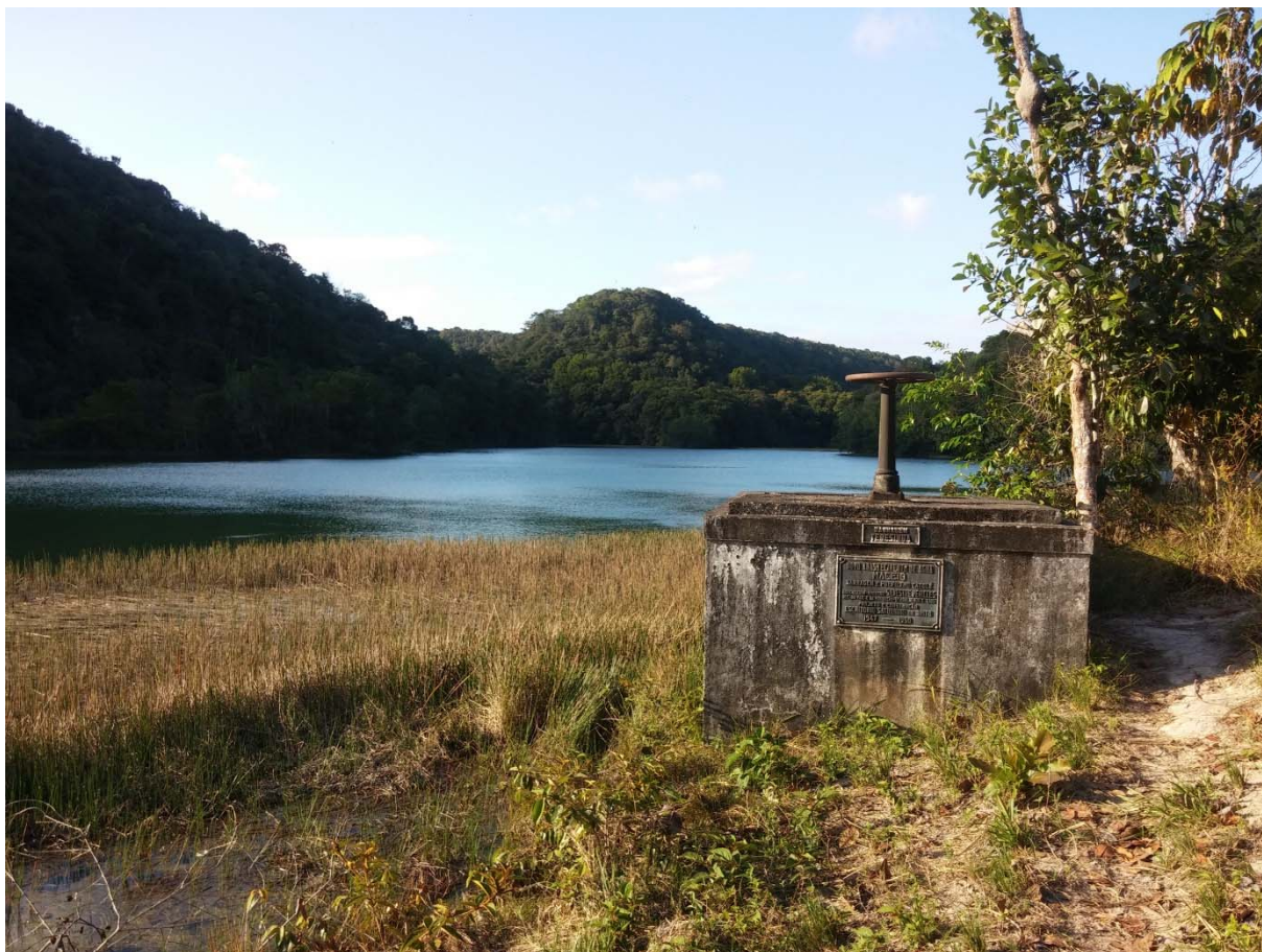
Figura 43. Reservatório da Barragem Catolé e registro da captação. Fonte MJ Engenharia.
