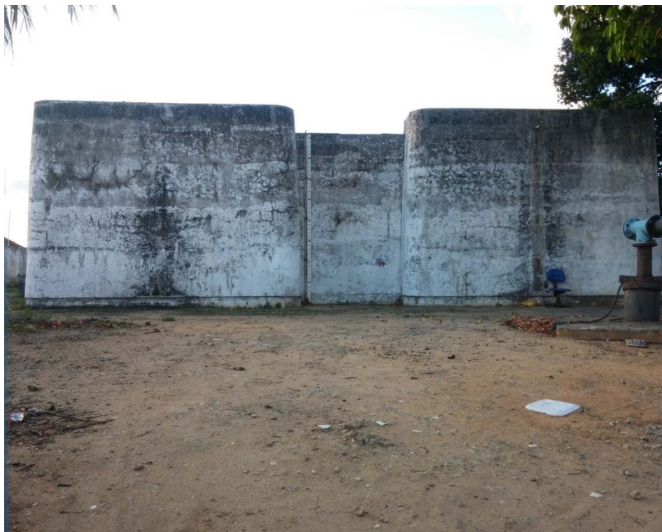
Figura 59. Reservatório R3A. Fonte MJ Engenharia.
