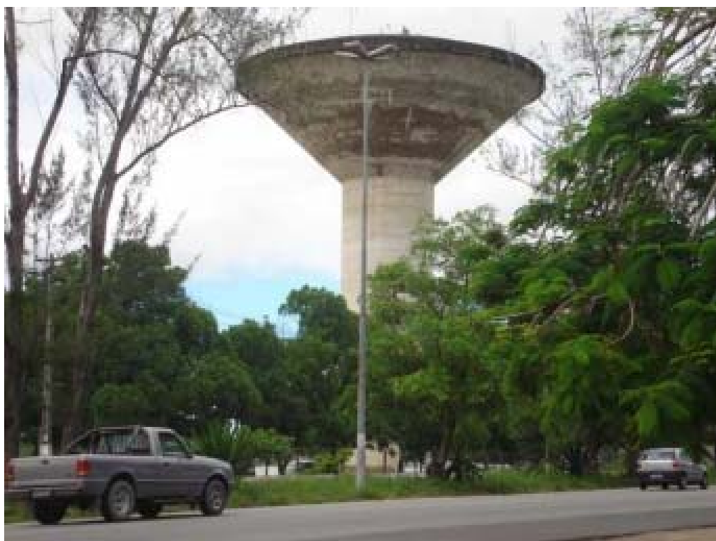
Figura 65. Reservatório do hospital universitário. Fonte: MJ Engenharia.
