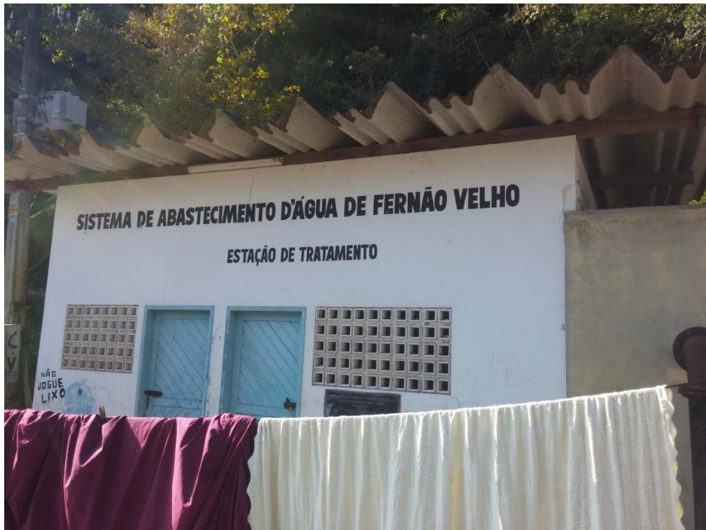
Figura 87. Casa de máquinas da ETA Fernão Velho. Pode-se ver pela imagem que o terreno onde está a ETA não é cercado e os moradores fazem uso do espaço. Fonte: MJ Engenharia.
