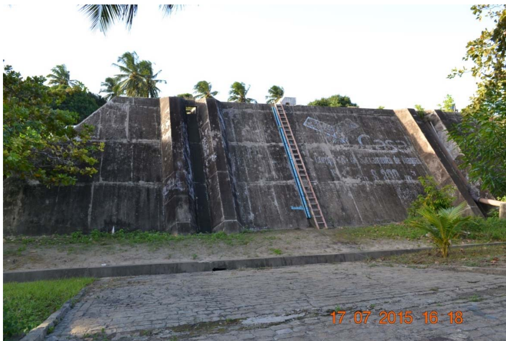
Figura 42. Reservatório R 01. Fonte: MJ Engenharia.
