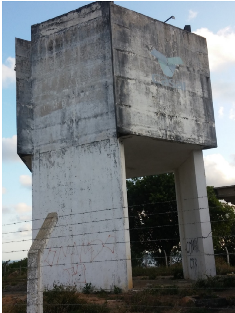
Figura 56. Reservatório R8. Fonte: MJ Engenharia
