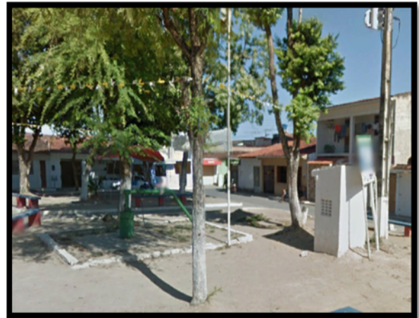
Figura 78. Poço de captação da CASAL
