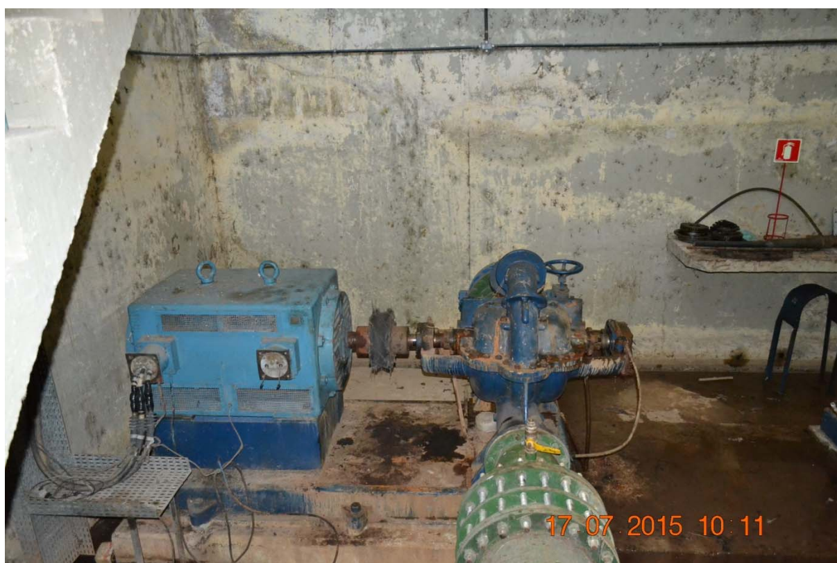
Figura 27. Bombas da Estação de Bombeamento de Água Bruta. Fonte: MJ Engenharia.
