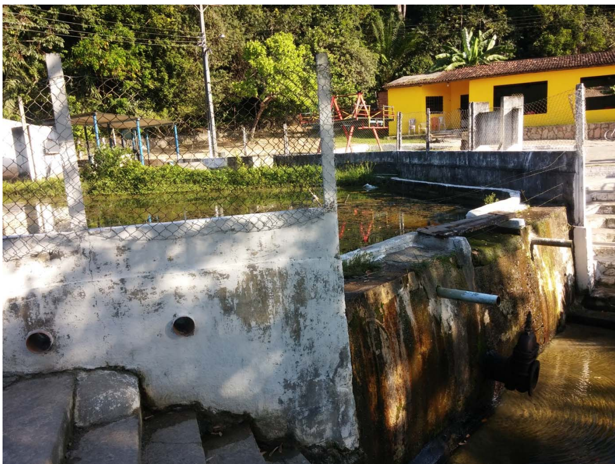
Figura 60. Barragem artesanal usada na captação do sistema aviação - recebe águas do riacho aviação, do riacho castor e sobras do riacho Catolé. Fonte MJ Engenharia.
