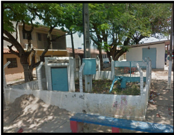
Figura 77. Poço de captação da CASAL
