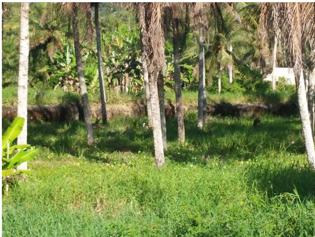
Figura 47. Fotografia do aqueduto, em seção circular, identificando a vegetação que cresce sobre o aqueduto, cujas raízes perfuram o mesmo, causando vazamentos e obstruções.
