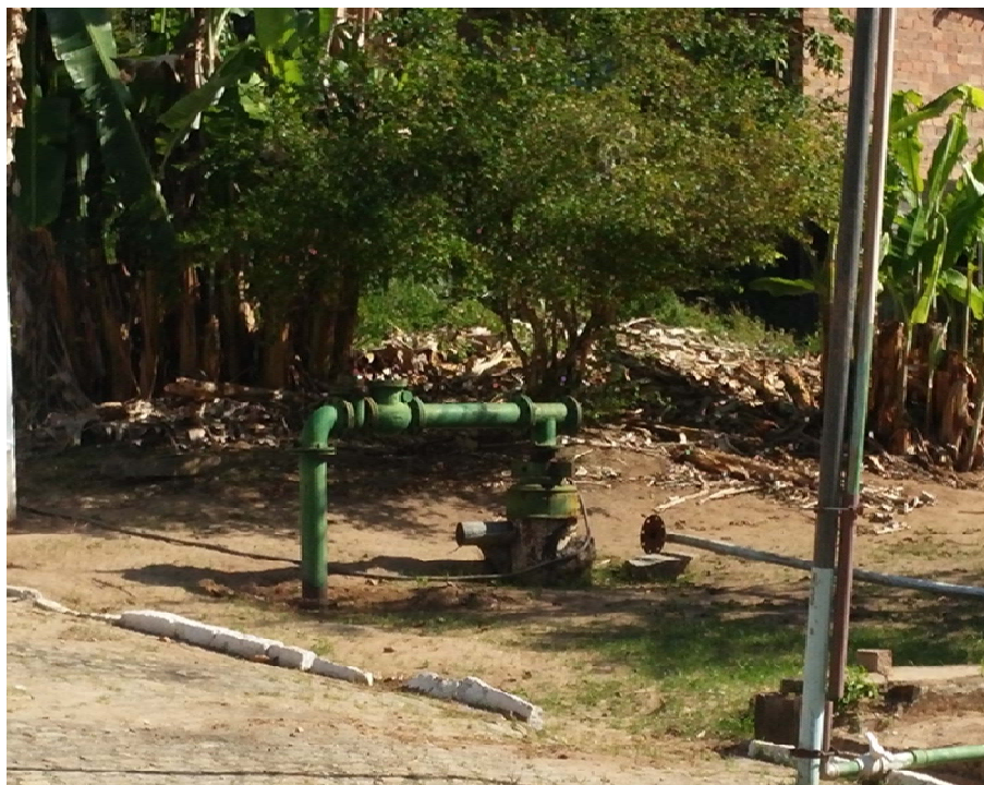
Figura 55. Poço PB8, utilizado para a complementação da captação de água, localizado junto a ETA Cardoso. Fonte: MJ Engenharia.
