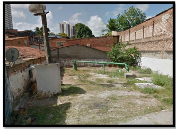
Figura 76. Poço de captação da CASAL
