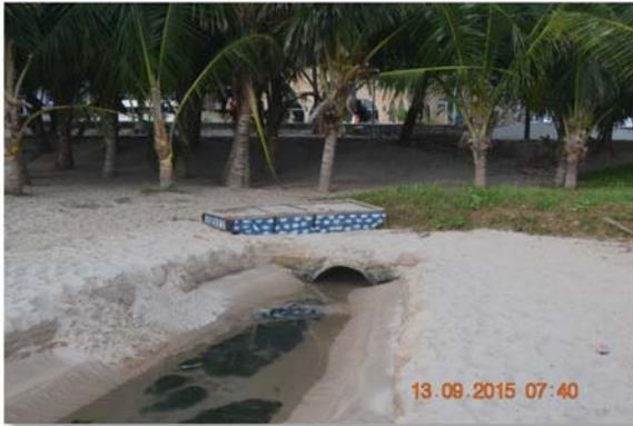
Figura 56 - Ponto de ocorrência de “língua negra” na praia da Ponta Verde que marca a drenagem pluvial com elevado conteúdo de esgoto sem tratamento prévio despejada diretamente no oceano. Fonte: MJ Engenharia. Data do Registro: 13/09/2015.
