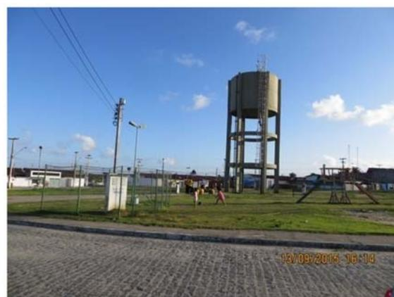
Figura 13 - Detalhe do reservatório utilizado para armazenar água captada pelos sistemas de poços no bairro Cidade Universitária. Fonte: MJ Engenharia. Data do Registro: 13/09/2015.
