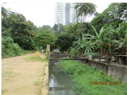
Figura 68 - Assoreamento acentuado do canal fluvial do riacho Reginaldo. Fonte: MJ Engenharia. Data do Registro: 17/09/2015.
