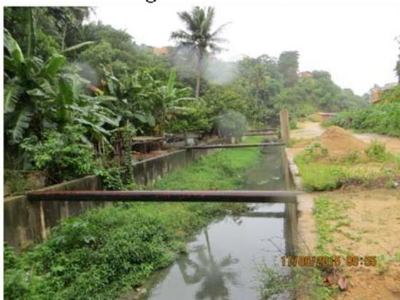
Figura 25 - Retificação linear do canal, com destaque para o assoreamento do canal e vegetação insurgente na área da seção. Fonte: MJ Engenharia. Data do Registro: 17/09/2015.
