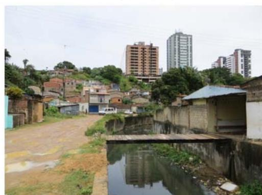
Figura 69 - Assoreamento associado à disposição irregular de resíduos e contaminação das águas do riacho Reginaldo. Fonte: MJ Engenharia. Data do Registro: 17/09/2015.
