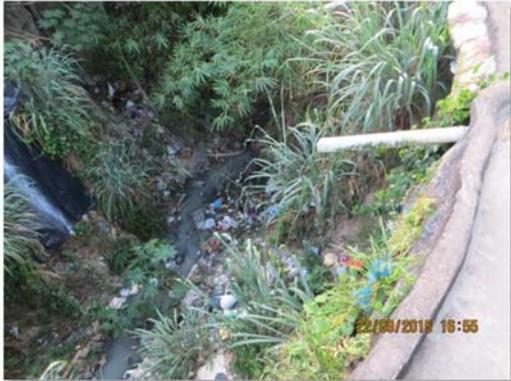
Figura 78 - Detalhe de ponto de lançamento de efluentes sem tratamento em área de ocupação de margem do canal fluvial. Fonte: MJ Engenharia. Data do Registro: 22/09/2015.
