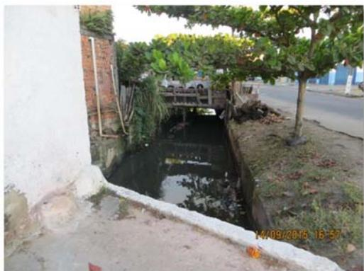
Figura 72 - Acentuada degradação da qualidade da água no canal localizado na Av. Celeste Bezerra devido ao despejo sem tratamento prévio de efluentes sanitários. Em menor escala nota-se também a dispersão de resíduos sólidos no canal. Fonte: MJ Engenharia. Data do Registro: 14/09/2015.
