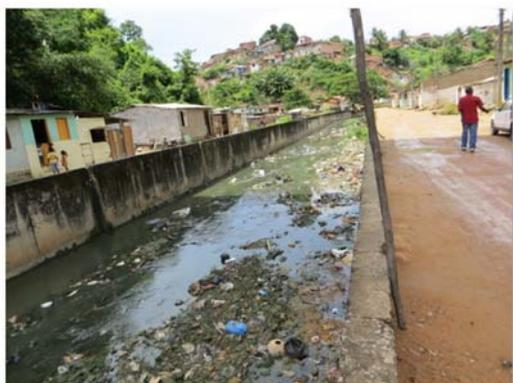
Figura 76 - Assoreamento associado à disposição irregular de resíduos e contaminação das águas do riacho Reginaldo. Fonte: MJ Engenharia. Data do Registro: 17/09/2015.
