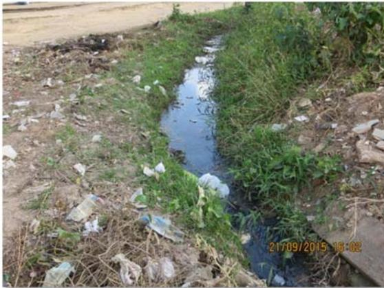
Figura 38 - Lançamento de esgoto in natura em canal escavado. Fonte: MJ Engenharia. Data do Registro: 21/09/2015.
