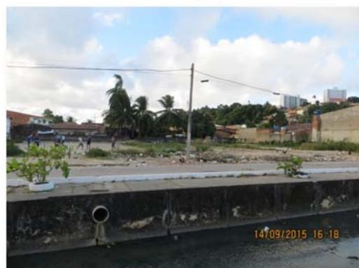
Figura 67 - Tubulação de despejo de drenagem pluvial diretamente no riacho Reginaldo com elevada carga de contaminantes orgânicos oriunda de efluente sanitário sem tratamento. Fonte: MJ Engenharia. Data do Registro: 14/09/2015.
