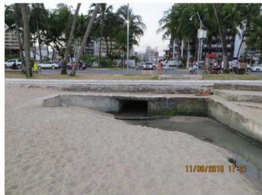
Figura 53 - Ponto de ocorrência de “língua negra” na praia da Pajuçara que marca a drenagem pluvial com elevado conteúdo de esgoto sem tratamento prévio despejada diretamente no oceano. Fonte: MJ Engenharia. Data do Registro: 11/09/2015.
