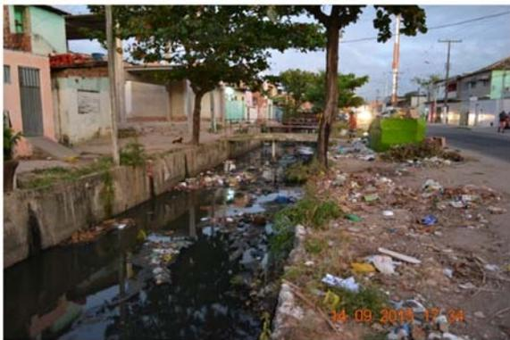
Figura 62 - Canal contaminado por elevadíssimo volume de efluentes sanitários sem tratamento prévio e por grande quantidade de resíduos sólidos domiciliares dispostos irregularmente. Fonte: MJ Engenharia. Data do Registro: 14/09/2015.
