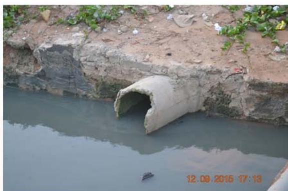
Figura 54 - Ponto de ocorrência de “língua negra” na praia que marca a drenagem pluvial com elevado conteúdo de esgoto sem tratamento prévio despejada diretamente no oceano. Fonte: MJ Engenharia. Data do Registro: 12/09/2015.
