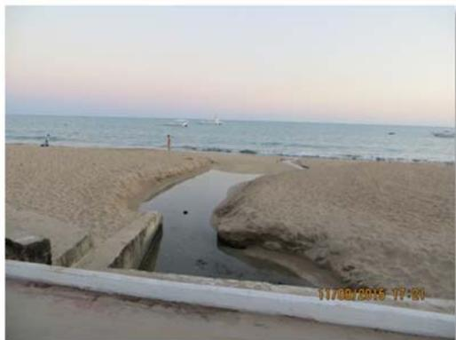
Figura 52 - Ponto de ocorrência de “língua negra” na praia da Pajuçara que marca a drenagem pluvial com elevado conteúdo de esgoto sem tratamento prévio despejada diretamente no oceano. Fonte: MJ Engenharia. Data do Registro: 11/09/2015.
