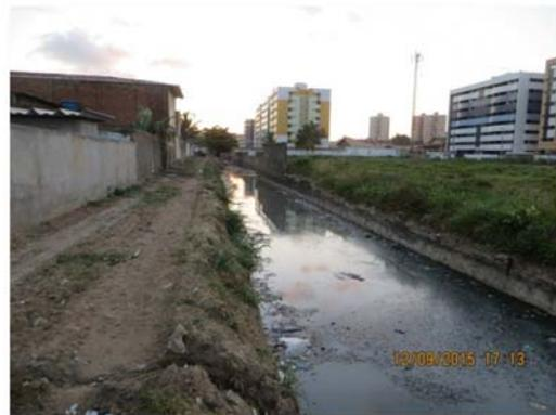
Figura 65 - Canal contaminado por elevadíssimo volume de efluentes sanitários sem tratamento prévio. Fonte: MJ Engenharia. Data do Registro: 12/09/2015.
