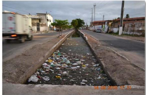
Figura 61 - Outra vista do canal contaminado por um elevadíssimo volume de efluentes sanitários sem tratamento prévio e por grande quantidade de resíduos sólidos domiciliares dispostos irregularmente. Fonte: MJ Engenharia. Data do Registro: 14/09/2015.
