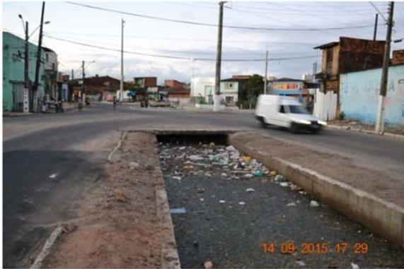
Figura 60 - Canal do contaminado por um elevadíssimo volume de efluentes sanitários sem tratamento prévio e por grande quantidade de resíduos sólidos domiciliares dispostos irregularmente. Fonte: MJ Engenharia. Data do Registro: 14/09/2015.
