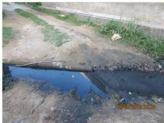
Figura 20 - Lançamento de esgoto in natura na área urbana do bairro Riacho Doce. Fonte: MJ Engenharia. Data do Registro: 12/09/2015.
