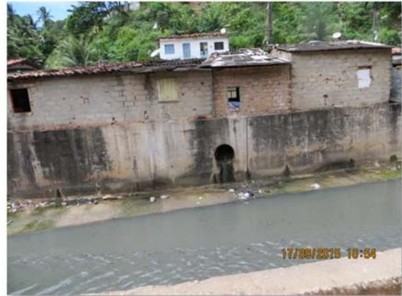
Figura 28 - Ponto de emissão de pluviais com elevada carga orgânica proveniente de esgotamento sanitário sem tratamento. Fonte: MJ Engenharia. Data do Registro: 17/09/2015.
