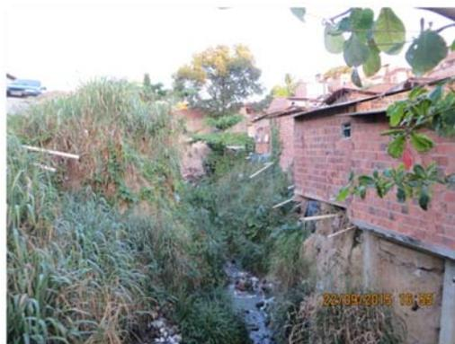
Figura 77 - Densa ocupação irregular da área de preservação permanente da margem esquerda do canal, onde observa-se também inúmeros pontos de lançamento de efluentes das residências para o canal fluvial. Cabe destacar que as edificações estão assentadas sobre talude íngreme o que configura risco geotécnico de desabamento. Fonte: MJ Engenharia. Data do Registro: 22/09/2015.
