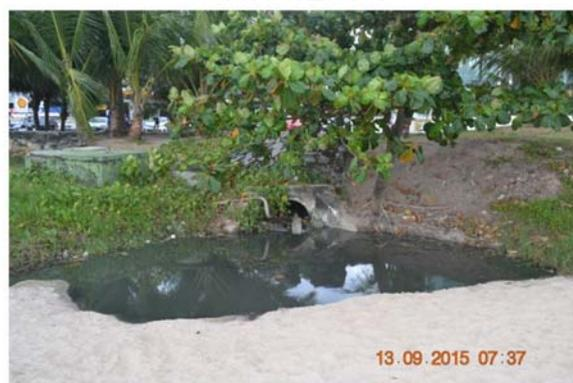
Figura 55 - Ponto de ocorrência de “língua negra” na praia da Ponta Verde que marca a drenagem pluvial com elevado conteúdo de esgoto sem tratamento prévio despejada diretamente no oceano. Fonte: MJ Engenharia. Data do Registro: 13/09/2015.
