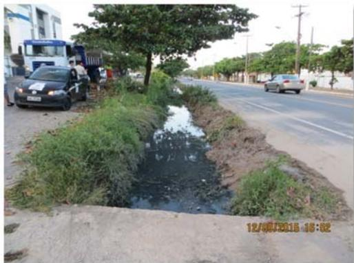
Figura 64 - Canal contaminado por elevadíssimo volume de efluentes sanitários sem tratamento prévio. Fonte: MJ Engenharia. Data do Registro: 12/09/2015.
