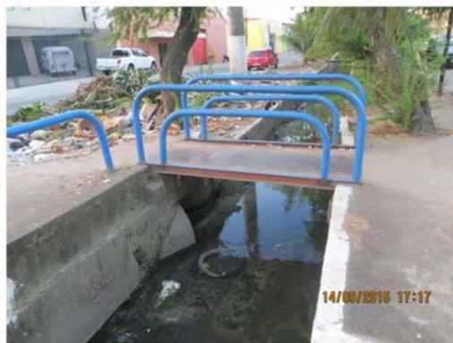
Figura 73 - Acentuada degradação da qualidade da água no canal localizado na rua João Calheiros devido ao despejo sem tratamento prévio de efluentes sanitários. Em menor escala nota-se também a dispersão de resíduos sólidos no canal. Fonte: MJ Engenharia. Data do Registro: 14/09/2015.
